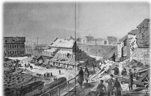
Fort Montrouge südlich Paris
