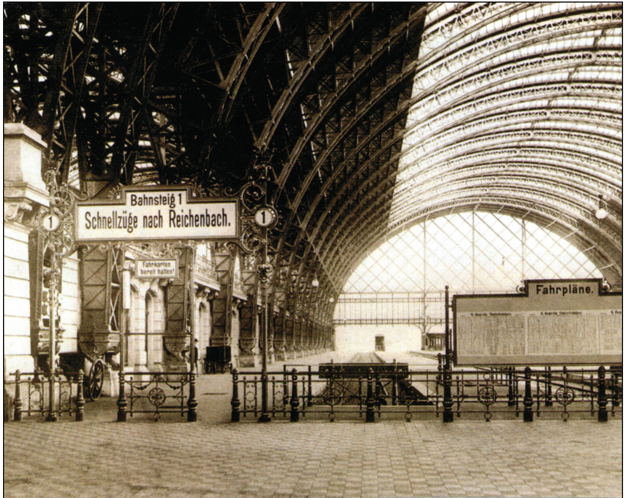
Abb. 8 Im 1898 vollendeten Hauptbahnhof Dresden war das Gleis 1 der Mittelhalle den zahlreichen D-Zügen nach Reichenbach vorbehalten.
